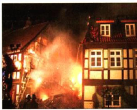
Großeinsatz der Feuerwehr in Wernigerodes Altstadt. In der Nacht zum Sonntagabend brannte ein Fachwerkhaus vollständig ab. Foto: Tom Koch
