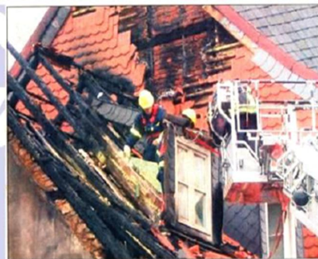
Zwei THW Helfer tragen die Dachgauben des Gebäudes ab, um die Last zu mindern.
